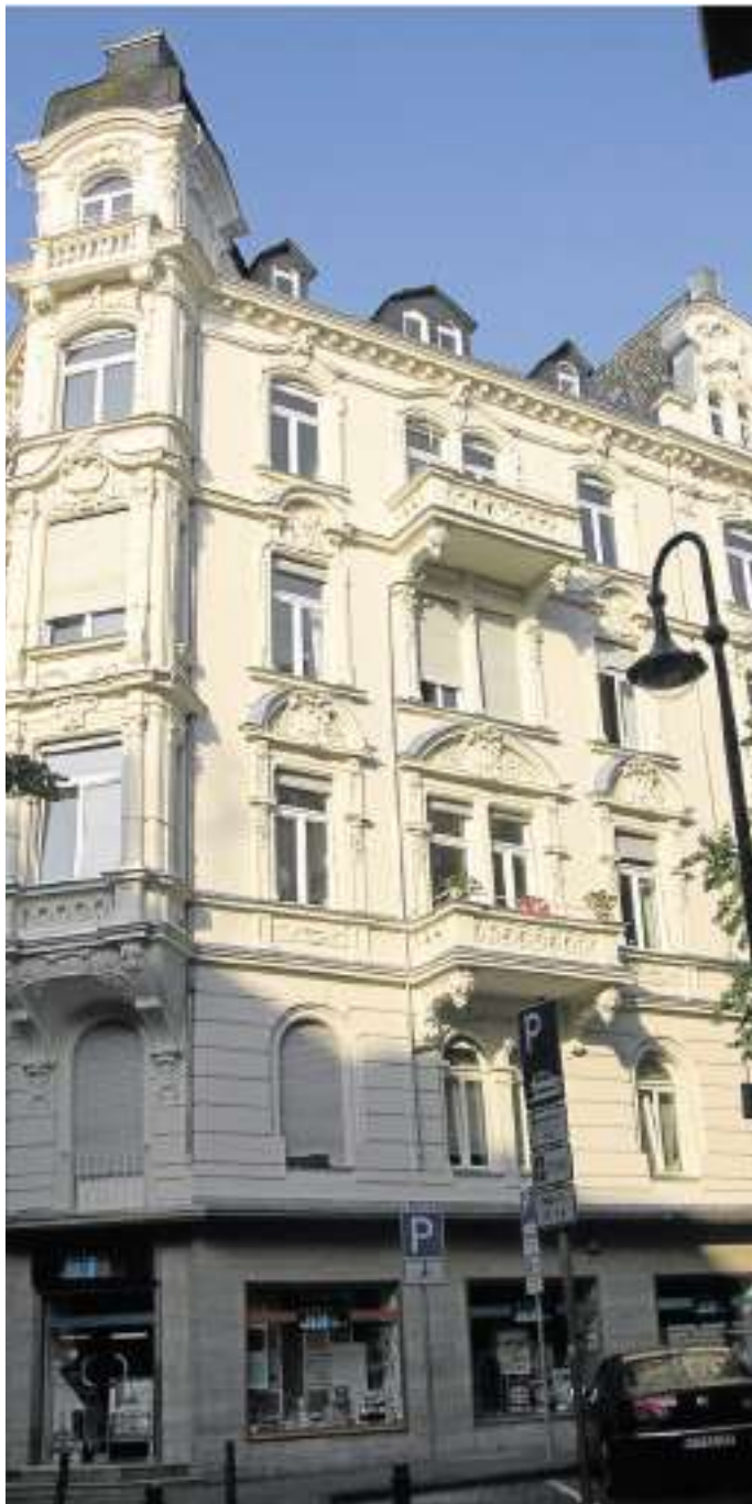
Wieder ein Schmuckstück: das Haus an der Ecke Luxemburg-/Herderstraße. Foto: Bleidner GmbH
